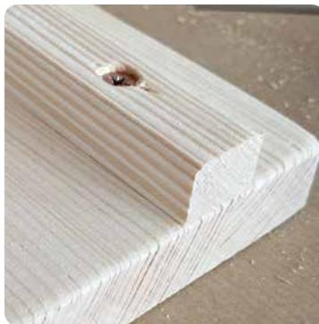
**13** Die Leiste mit einer Holzschraube 4 x 30 mm lose anschrauben, gerade auf dem Brett ausrichten und am anderen Ende das zweite Loch vorbohren. Links und rechts anschrauben, bis die
