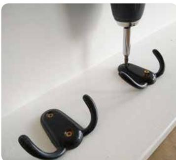
**21** Die Haken mit dem Twercs® Akku-Bohrschrauber festschrauben. Hierfür die Holzschrauben 3 x 20 mm verwenden.
