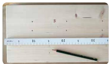
**16** Nach außen mit 10 cm Abstand und dazwischen mit je 20 cm Abstand Löcher für die Schrauben anzeichnen und vorbohren. Diese Schrauben werden die Rückwand mit dem Regalboden verbinden, deswegen ist es wichtig,
