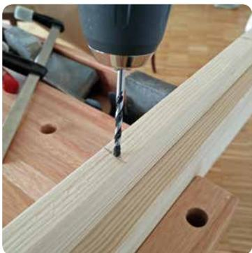
**18** Den Regalboden senkrecht einspannen und in die rückwärtige Kante die Löcher vorbohren. Nur ein paar Millimeter vorbohren, sodass die Schrauben Halt finden, wenn nun der Regalboden an die Rückwand montiert wird. Die Rückwand auflegen und anschrauben.
