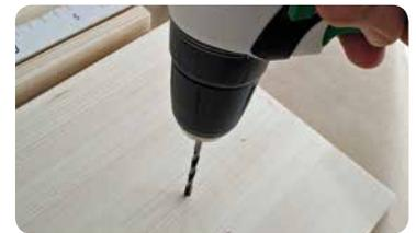
**10** Die Löcher für die Haken anzeichnen und nur in tief vorbohren.
