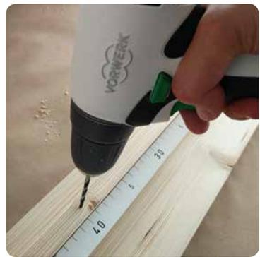
**14** In gleichmäßigen Abständen von ca. 12 cm weitere Löcher jeweils bis zum unteren Brett vorbohren und die Leiste mit weiteren Schrauben festschrauben.
