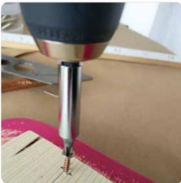
**23** Das Rückenbrett mit zwei Schrauben links und rechts mit ca. 1,5 cm Abstand zum Rand an die Rückseite des Bords anschrauben.
